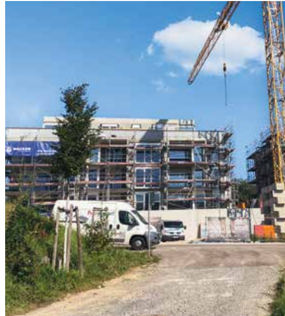
Eines der zwei von Wacker schlüsselfertig gebauten Mehrfamilienhäuser in Pfinztal-Söllingen, die voraussichtlich Ende 2023 fertig werden
