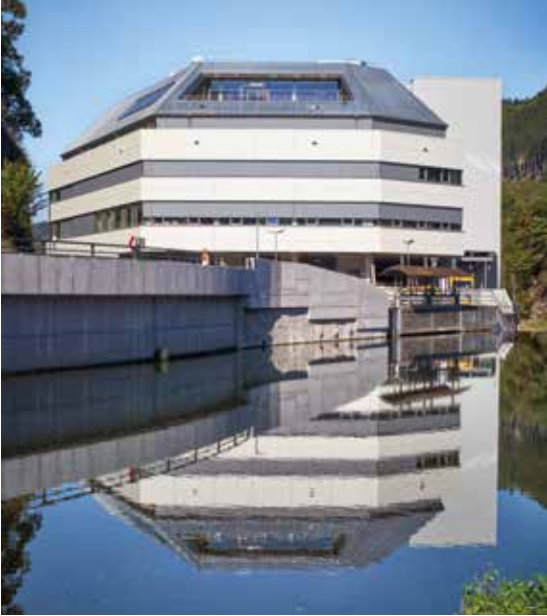
Zwischen Fluss und Hauptstraße: Der Neubau für den Messtechnikspezialisten VEGA Grieshaber in Schiltach im Kinzigtal erforderte besondere Lösungen
