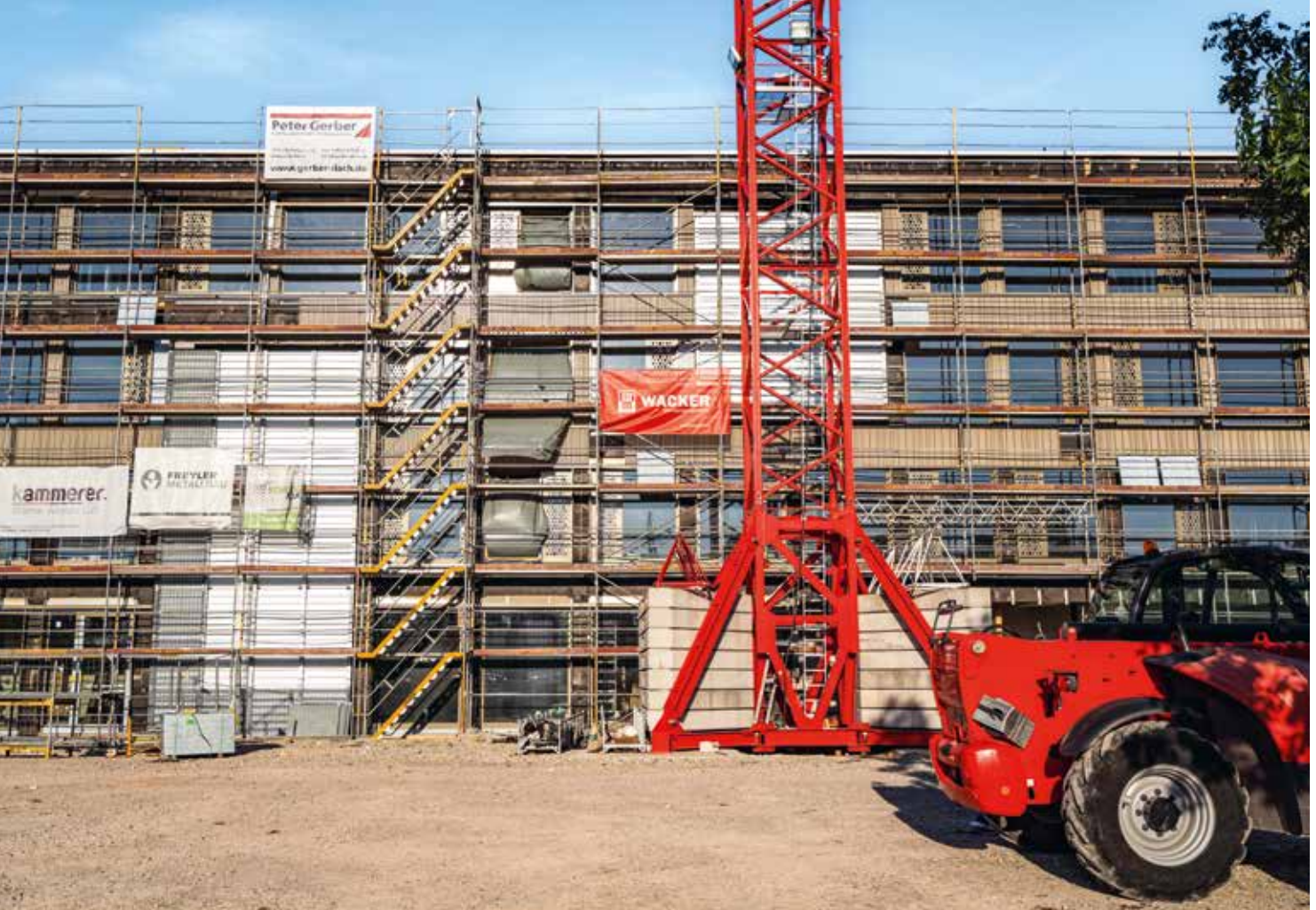
Das Projekt in Zahlen: 2315 Kubikmeter Beton und 235 Tonnen Stahl sind hier verbaut
