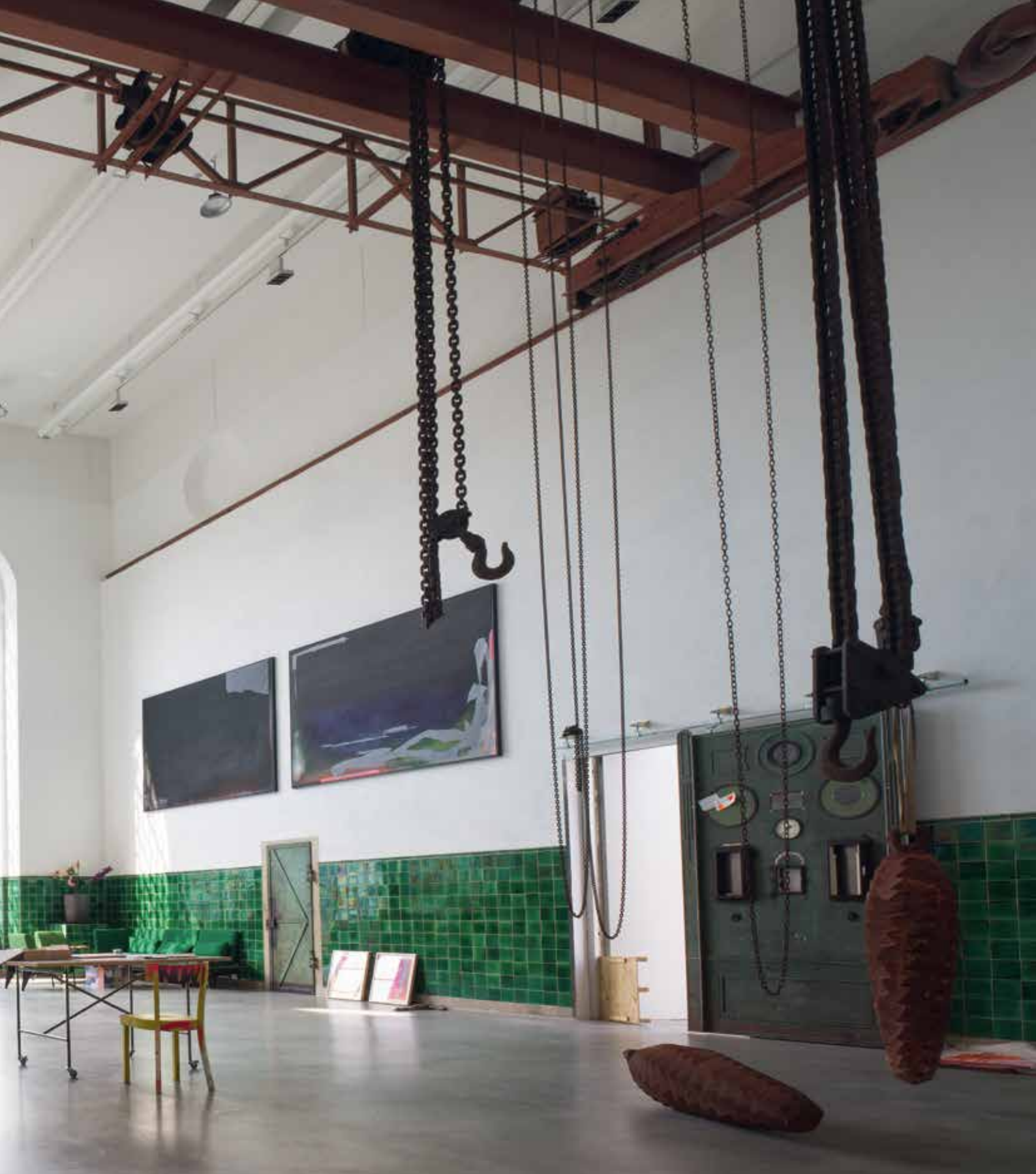
Ein Traum von Raum: der Maschinensaal im Kesselhaus nach Abschluss der Umbauarbeiten
